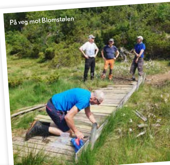
Montering av bord på Kyststien til Flokehytene, Ryvarden.
