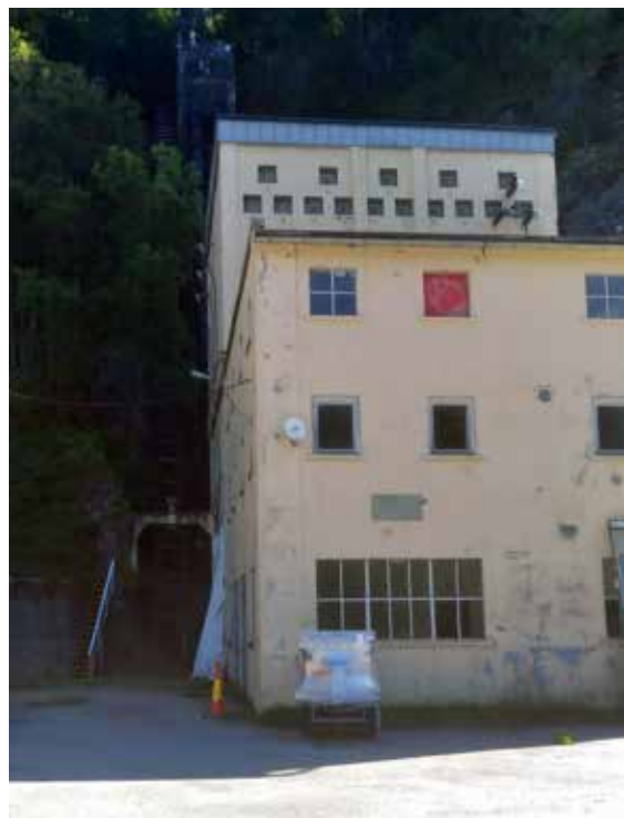
Den nedlagte kraftstasjonen Sauda I.
