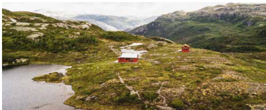
Simlebu i dag. Nye hytta skal til høyre i bildet, nærmere kanten.
