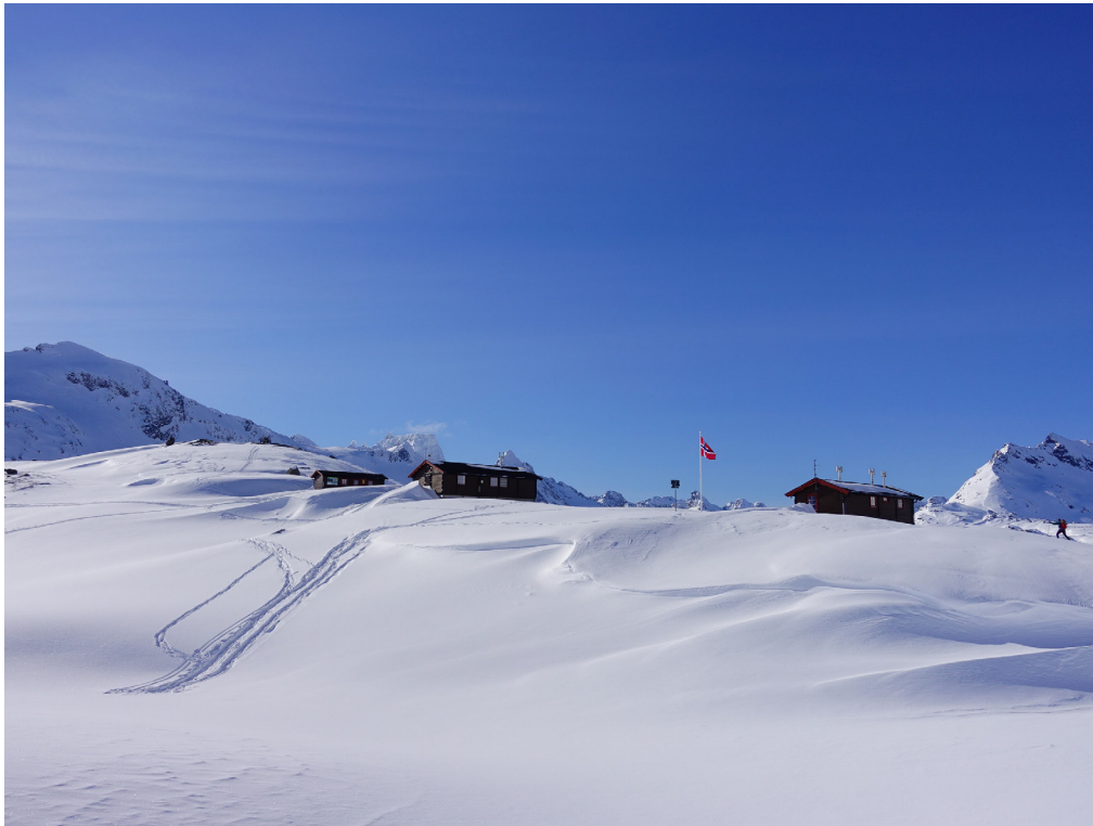
SNYTINDHYTTA I VESTERÅLEN MED SIKRINGSHYTTE/TILSYNSHYTTE TIL HØYRE, HOVEDHYTTE 40 METER OVAFOR DENNE OG UTHUS MED TOALETT 20 METER VIDERE TIL VENSTRE.
