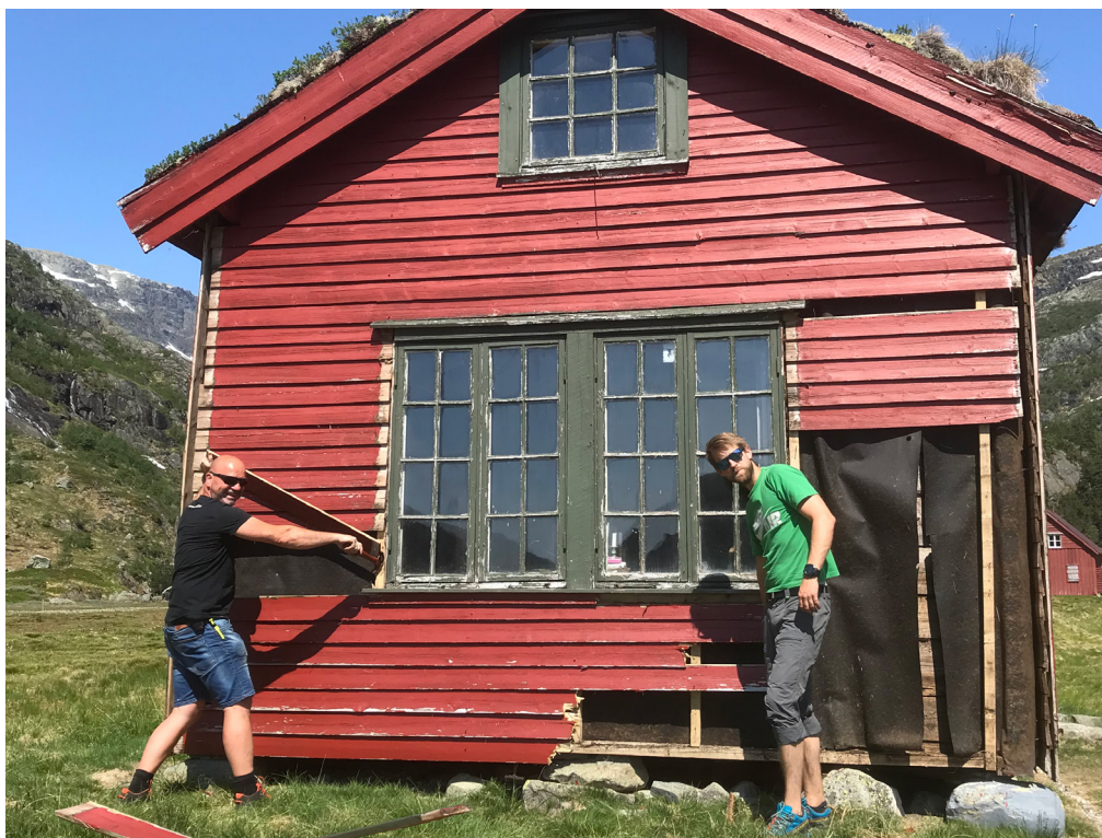
BILDET VISER UTSKIFTING AV KLEDNING PÅ KVANNDALEN
