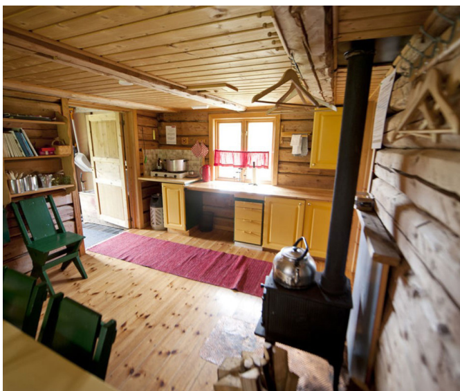
↑ Bilde 1: Eksempel på en løsning som ikke er brannsikker. Her er det hengt opp kleshenger direkte over ovnen.
