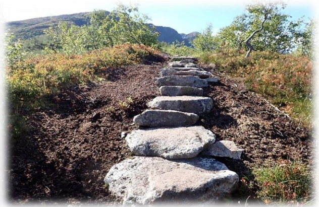
Eksempel på legging av steintrapp i hellande våtmark, her før og etter.
