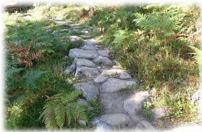
Steinsett sti, etter tiltak (til venstre) og før tiltak (til høyre)
