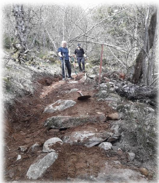
Utkøyring av topplag/grus manuelt og med minidumpar.
