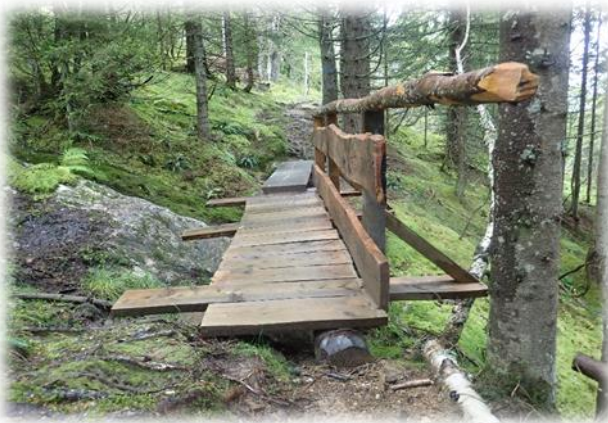
Eksempel på bru bygd med plank av kjerneved lerce.
