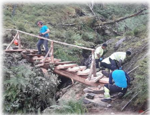
Eksempel 1: Trapp med underliggjande halvstokkar bygd av lerk frå nærområdet, og skåre med motorsag.
