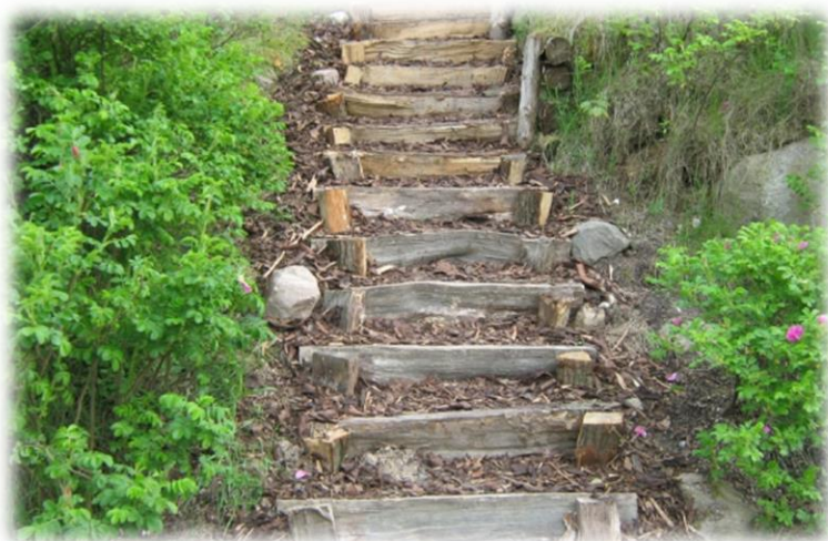
Eksempel 3: Trapp med tverrgående plank
