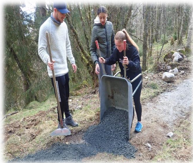
Utkøyring av topplag/grus manuelt og med minidumpar.
