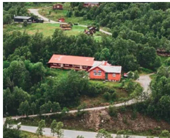
BJØRNEVASSHYTTA 820 moh 26 senger / Bygget/renovert: 1889/2009
