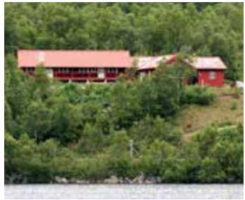
BJØRNEVASSHYTTA 820 moh 26 senger / Bygget/renovert: 1889/2009
