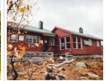
LAKKENSTOVA 845 moh 36 senger / Bygget/renovert: 1985/2011
