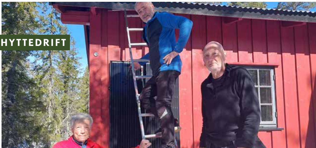
F.V Per Hægstad, Knut Hægstad og Vidar Aadalen har installert de fleste av anleggene og er her i ferd med å skru opp solcellepanelet på Hovlandshytta i Finnemarka.
