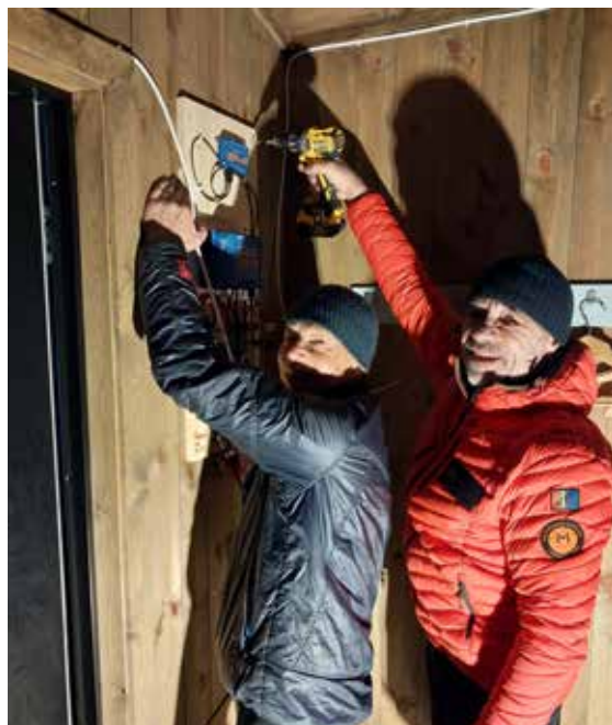
Brødrene Per og Knut Hægstad, monterer hjerte i solcelle anlegget. Bestående av teknisk utstyr fra Victron.
