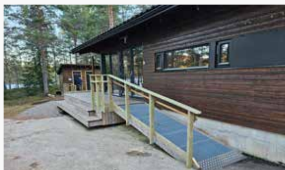
Rampen opp til hytta med rekkverk montert av våre frivillige, og etter gjeldene forskrifter og regler for tilgjengelighet. Foto: Privat.
