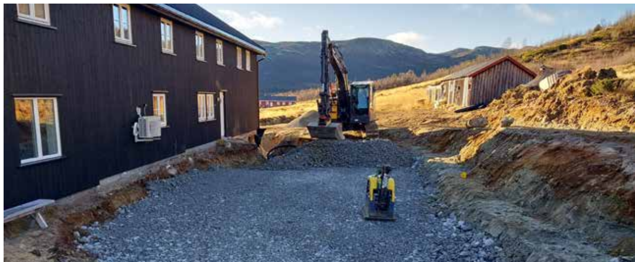
Grunnarbeidene startet midt i november. Planen er å få bygget under tak før vinteren setter i gang for fullt slik at vi kan jobbe innvendig i vinter. Foto: Johan Fegri.
