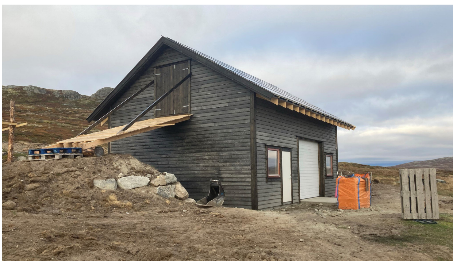
Ny Flor ferdig på Rauhelleren Foto: Hans Olav Lægneid
