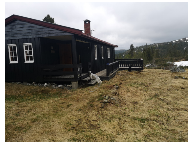
Ny hytte langs Vassfarstien, Røggjen. Foto: Johan Fegri
