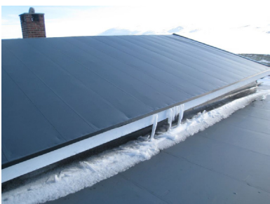
Mårbu, det nye taket med beslag. Foto: DNTD
