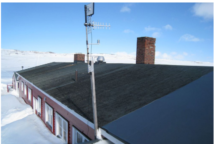
Mårbu, der det skal legges nytt Protan tak. Foto: DNTD
